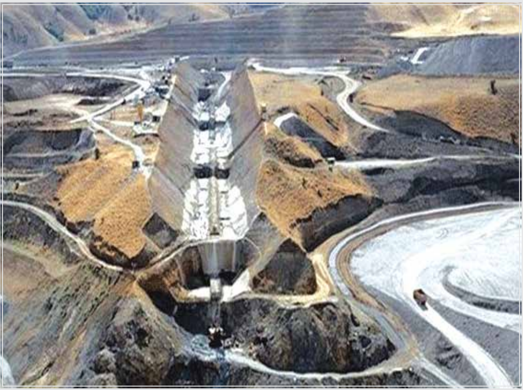
مدیرعامل شرکت آب منطقه‌ای قزوین گفت: پروژه بزرگ سد نهب در بخش تاکستان به پیشرفت ۹۸ درصدی رسیده است.
