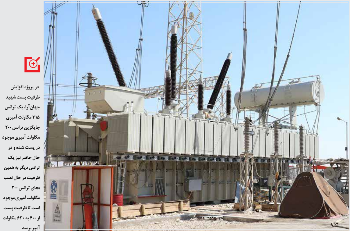
در پروژه افزایش ظرفیت پست شهید جهان آرا، یک ترانس ۳۱۵ مگاوات آمپری جایگزین ترانس ۲۰۰ مگاوات آمپری موجود در پست شده و در حال حاضر نیز یک ترانس دیگر به همین ظرفیت در حال نصب بجای ترانس ۲۰۰ مگاوات‌آمپری موجود است تا ظرفیت پست از ۴۰۰ به ۶۳۰ مگاوات آمپر برسد
