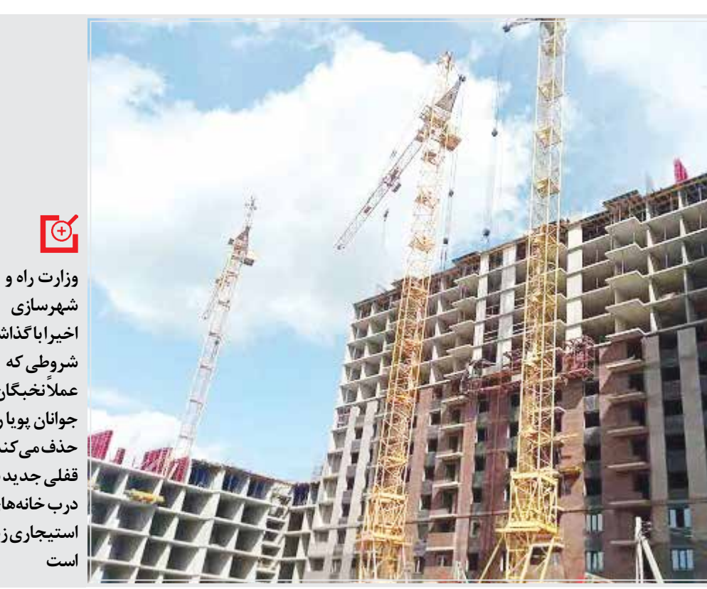
یک ساختمان مسکن در حال ساخت در تهران.
